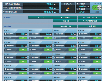
太陽光発電量遠隔監視画面
